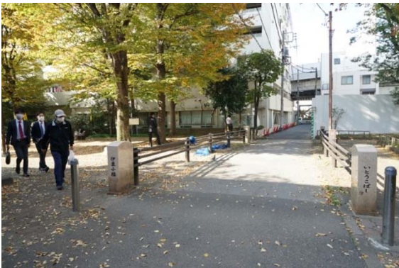
玉川上水旧水路緑道に残る橋の高欄。
