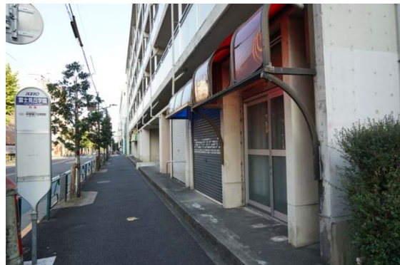
水道道路沿線の都営住宅1階は未利用空間が存在。
